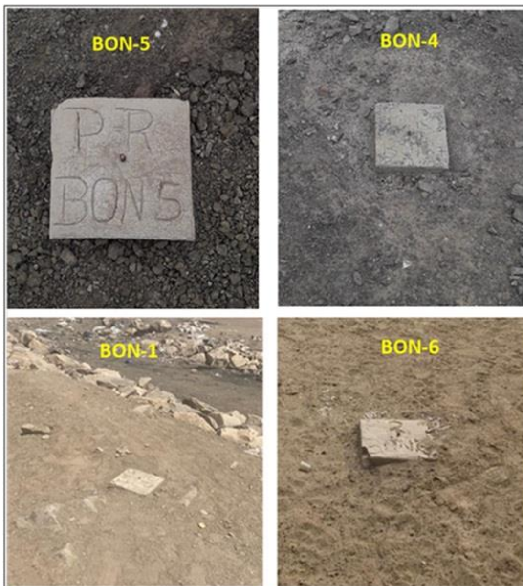
Figura 7.4 Fotografía de monolito de PRs existentes encontrados
