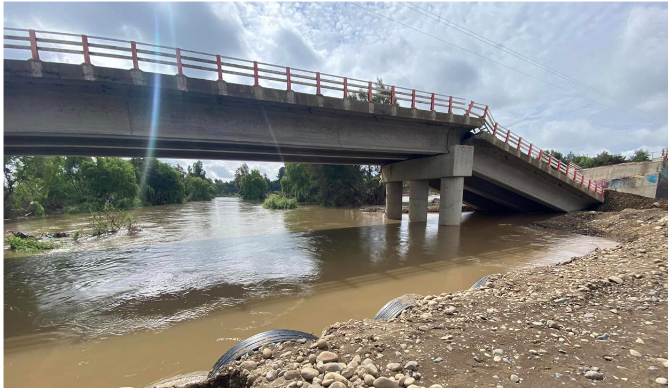
Reposición de puente Maitenhuapi Región del Maule
