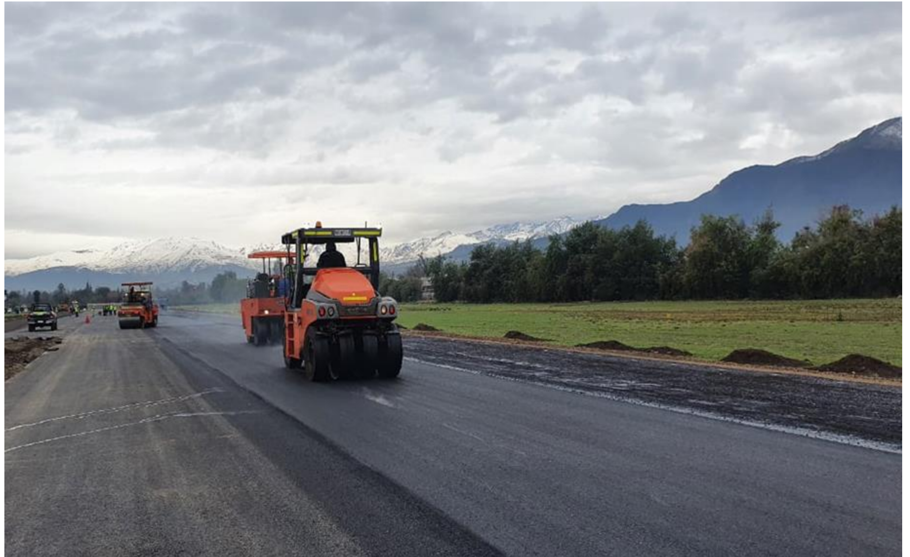
Reciclaje de pavimentos en proyectos aeroportuarios Región de Aysén
