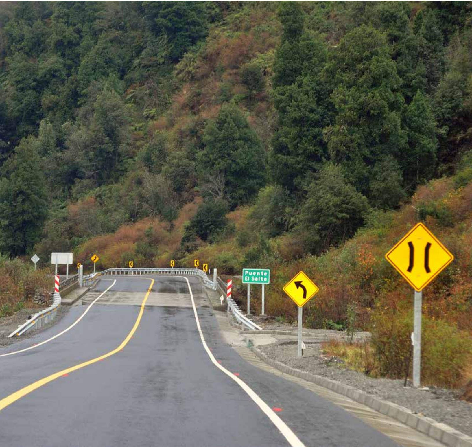
Ruta 7 Norte, Pavimentación Puente el Salto, Región de Aysén
