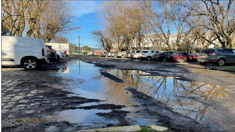
Figura 2. Condiciones Actuales del Estacionamiento Parque Estadio Germán Becker, ciudad de Temuco.
