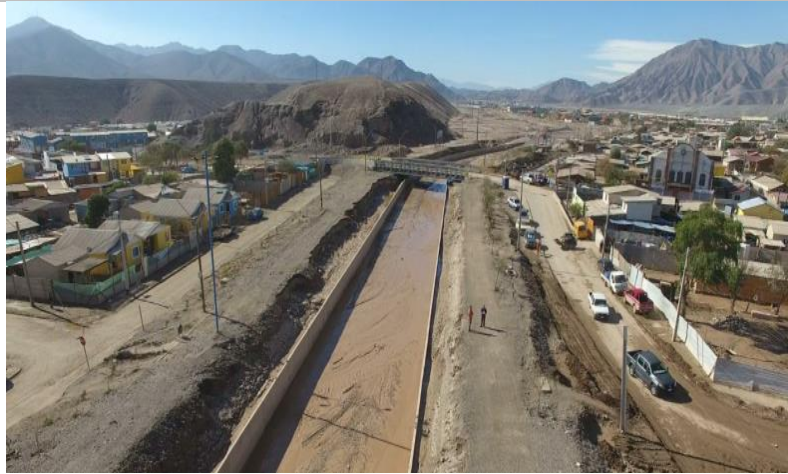
Ilustración 19. Revestimiento de cauce post 25M zona urbana se puede apreciar el puente mecano que conecta la calle 21 de Mayo en la ciudad de Copiapó Fuente: SEIA, 2018
