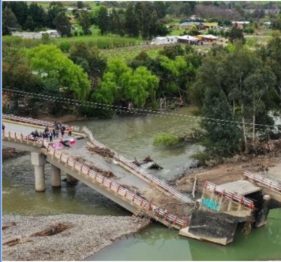
Reposición de puente Maitenhuapi Región del Maule
