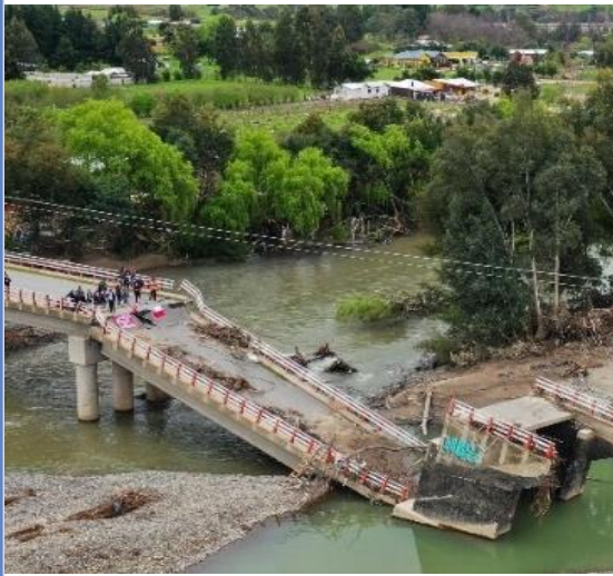
Reposición de puente Maitenhuapi Región del Maule
