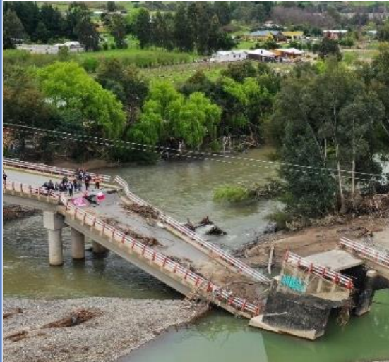
Reposición de puente Maitenhuapi Región del Maule
