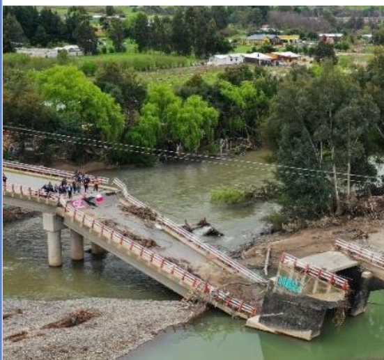
Reposición de puente Maitenhuapi Región del Maule
