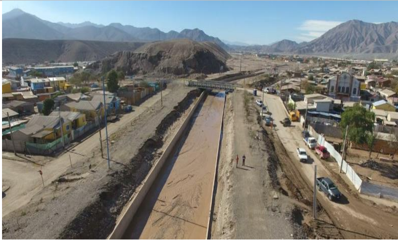
Ilustración 19. Revestimiento de cauce post 25M zona urbana se puede apreciar el puente mecano que conecta la calle 21 de Mayo en la ciudad de Copiapó Fuente: SEIA, 2018
