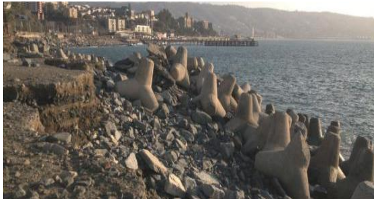
Ilustración 29. Desplazamiento de tetrápodos zona costera de la región de Valparaíso post evento Ago-2015 Fuente: Winckler; P., 2016
