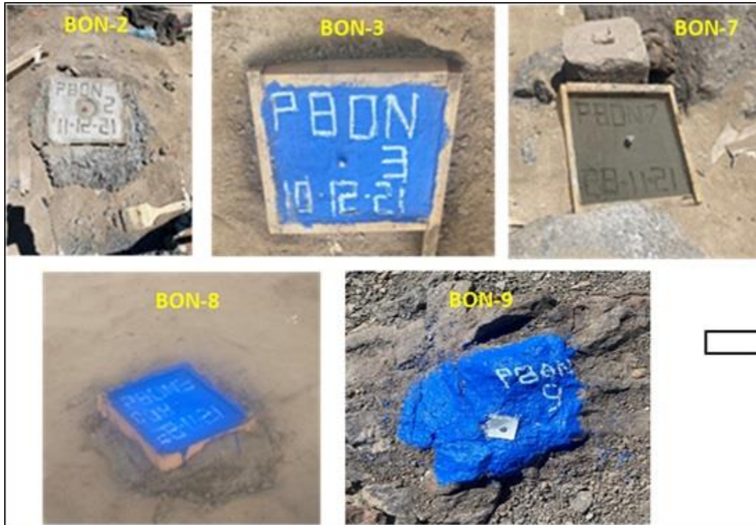
Figura 7.5 Fotografía de monolitos construidos
