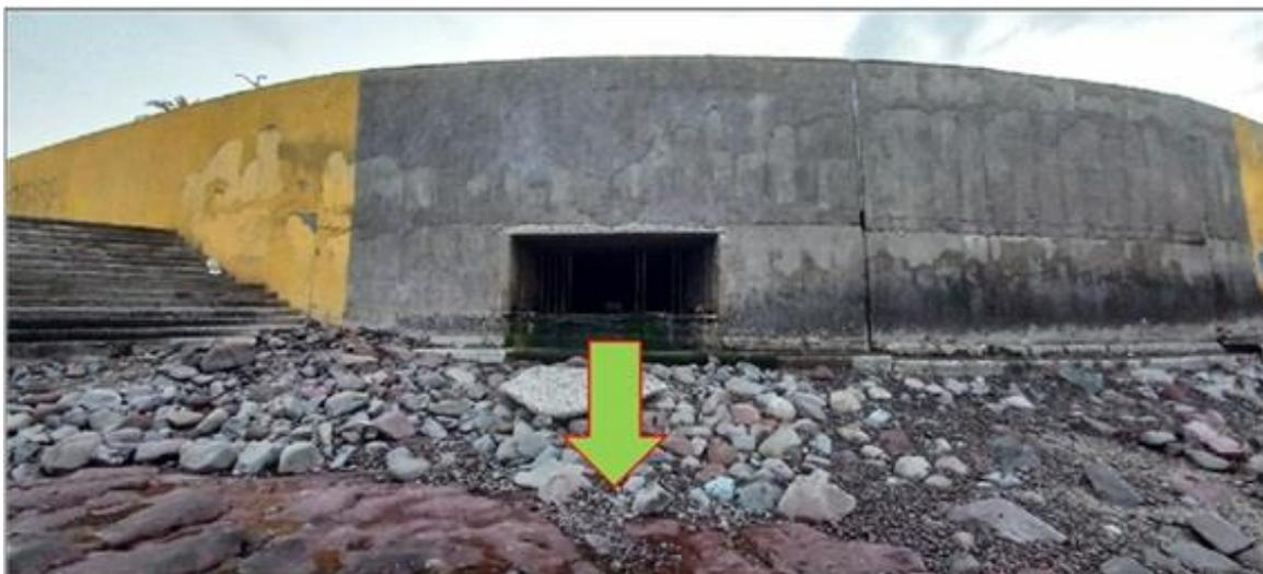
**Figura 12.2 Canalización en hormigón de la quebrada La Negra**
