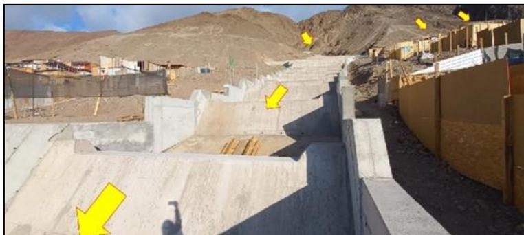
En el entorno de las obras se han instalado viviendas irregulares y hacia el sur, el muro tipo guardarradier construido para contener el flujo difuso de la ladera e interceptarlo mediante un canal colector conectado al canal de descarga de la obra disipadora paralelo a calle Martin Luther King, fue ocupado por viviendas.
