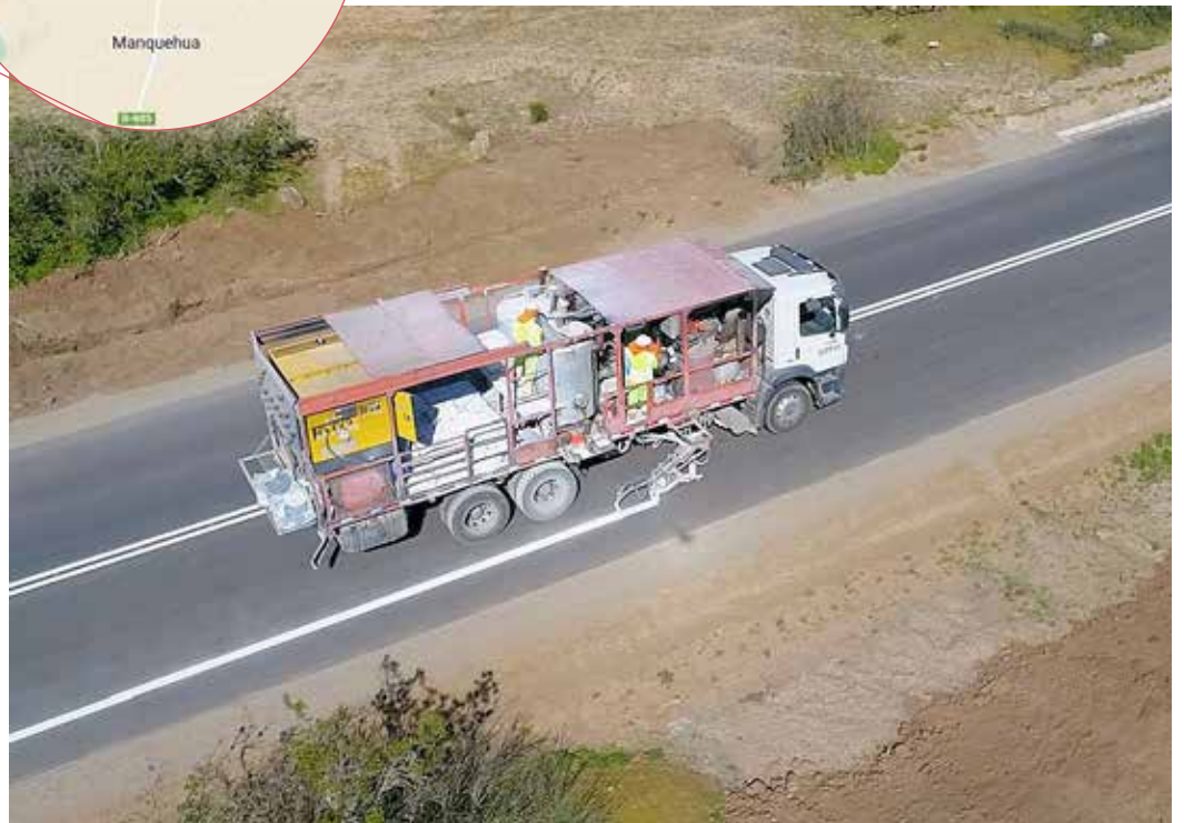
Figura 12: Avances de construcción camino. Fuente: Dirección de Vialidad
