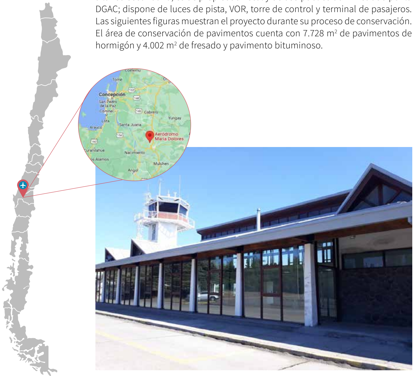
Figura 8: Vista renovación ventanas terminal pasajeros, Fuente: Archivo DAP.
