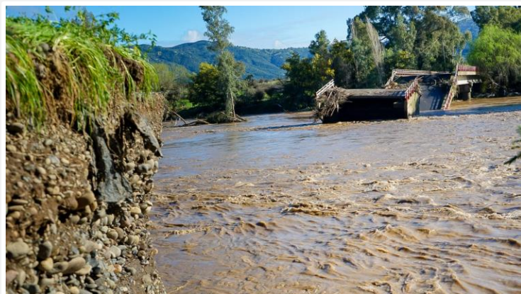
Puente Maitenhuapi, Región del Maule, agosto 2023
